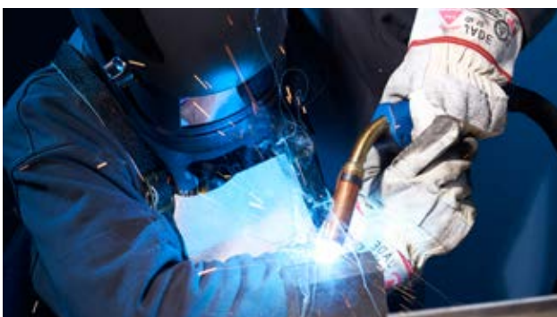
Oplassen van een beschadigd kantpersgereedschap (MAG-procedure)
